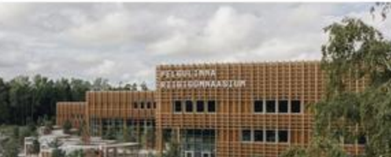
“Aasta puitehitis 2023” peaa FOTO: TÕNU TUNNEL
